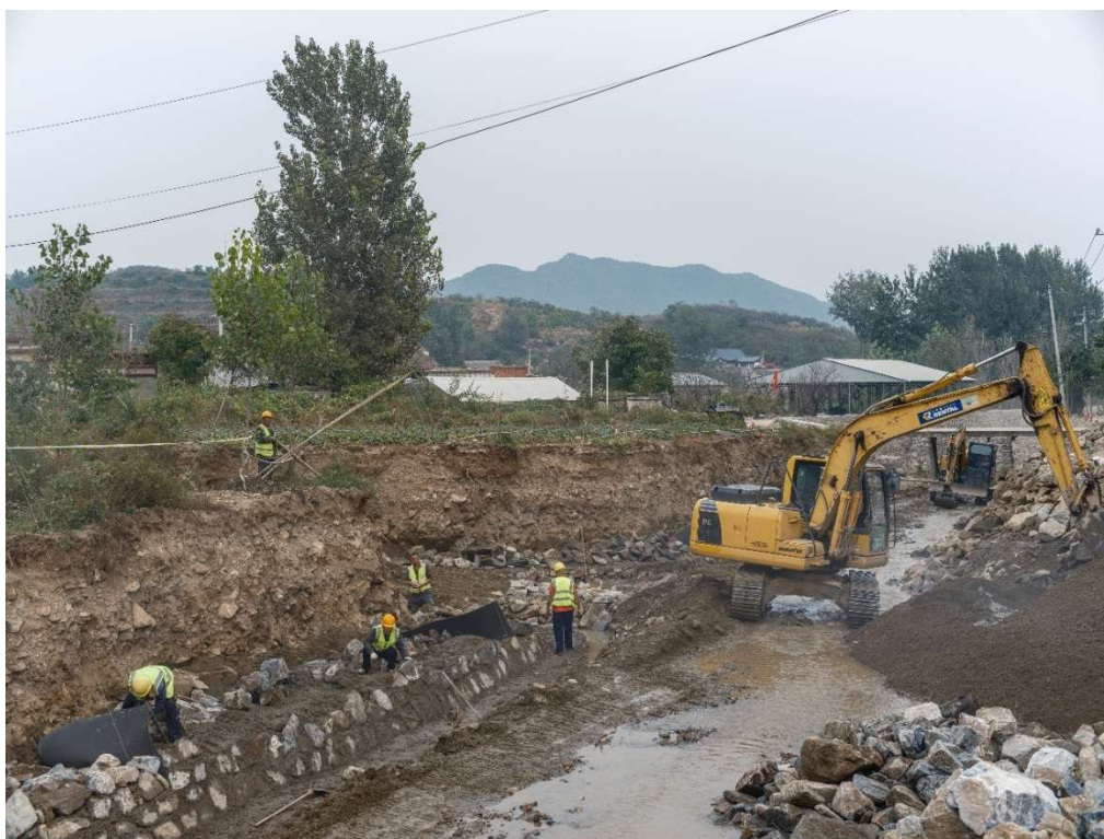
图 3-7 河北千山县八沟村的施工队正加紧修整河道与河堤，近些年河北夏季的雨量增多，重整河道能增强排涝防涝的能力。
