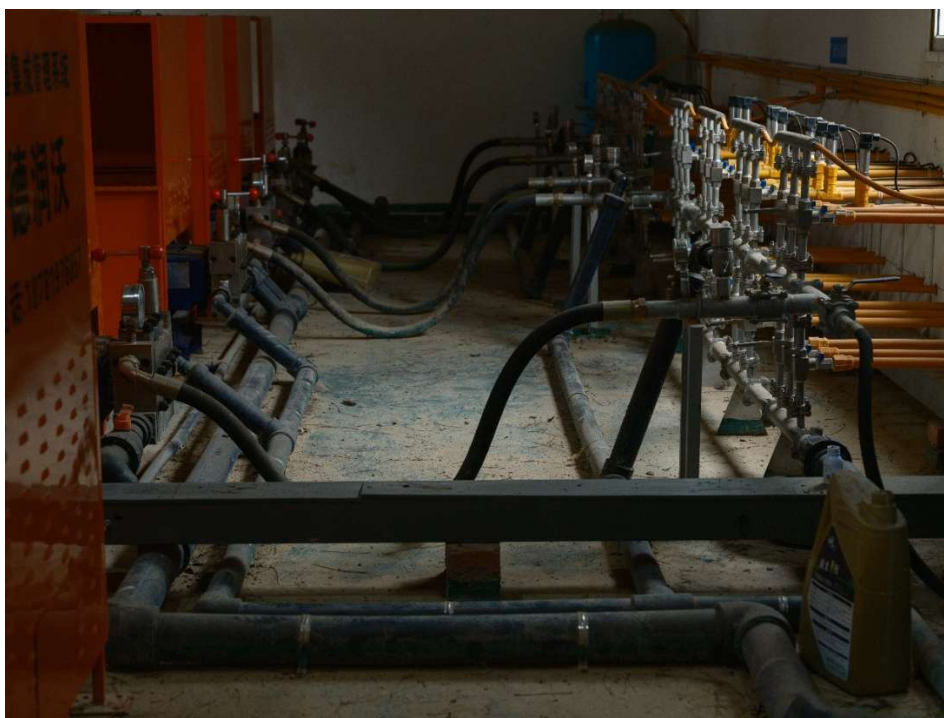
图 2-17 双林镇新田村的水肥一体化设施，村集体为有效提高产量购入这套设施，黄色的输送管道为梨园提供配制好的肥料，通过喷淋装置进行更高效、均匀的施肥。如果土地水份流失严重，则可用这套设备进行浇灌，避免梨树死亡。
