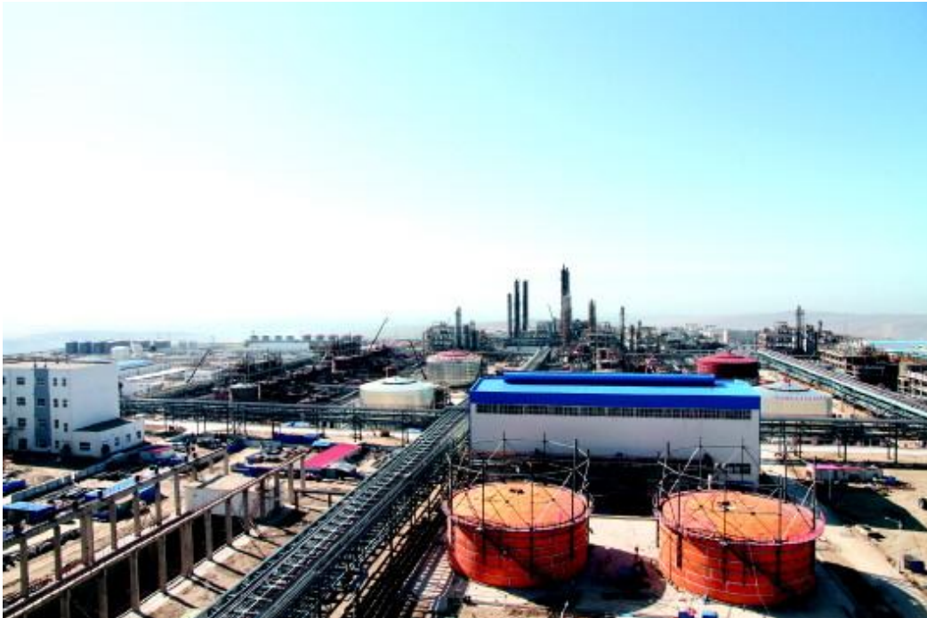
图：未拿到环评批复而完工度已超过80%的伊犁新天年产20亿立方米煤制燃气项目。（图片来源：大众日报 25 ）
