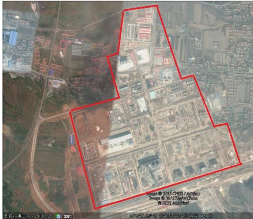
图：通过 GOOGLE EARTH 的卫星图可以看到，2014 年，未拿到环评的山西潞安项目就已经完成部分施工。
