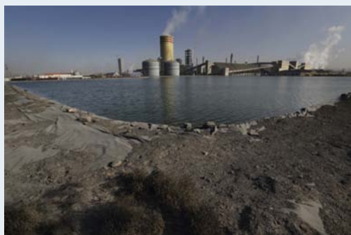
鄂尔多斯联合化工有限公司在棋盘锦工业园区，污水排放 10000 平方米的水池，水满时再排放沙滩渗透 © 邱波 / 绿色和平
