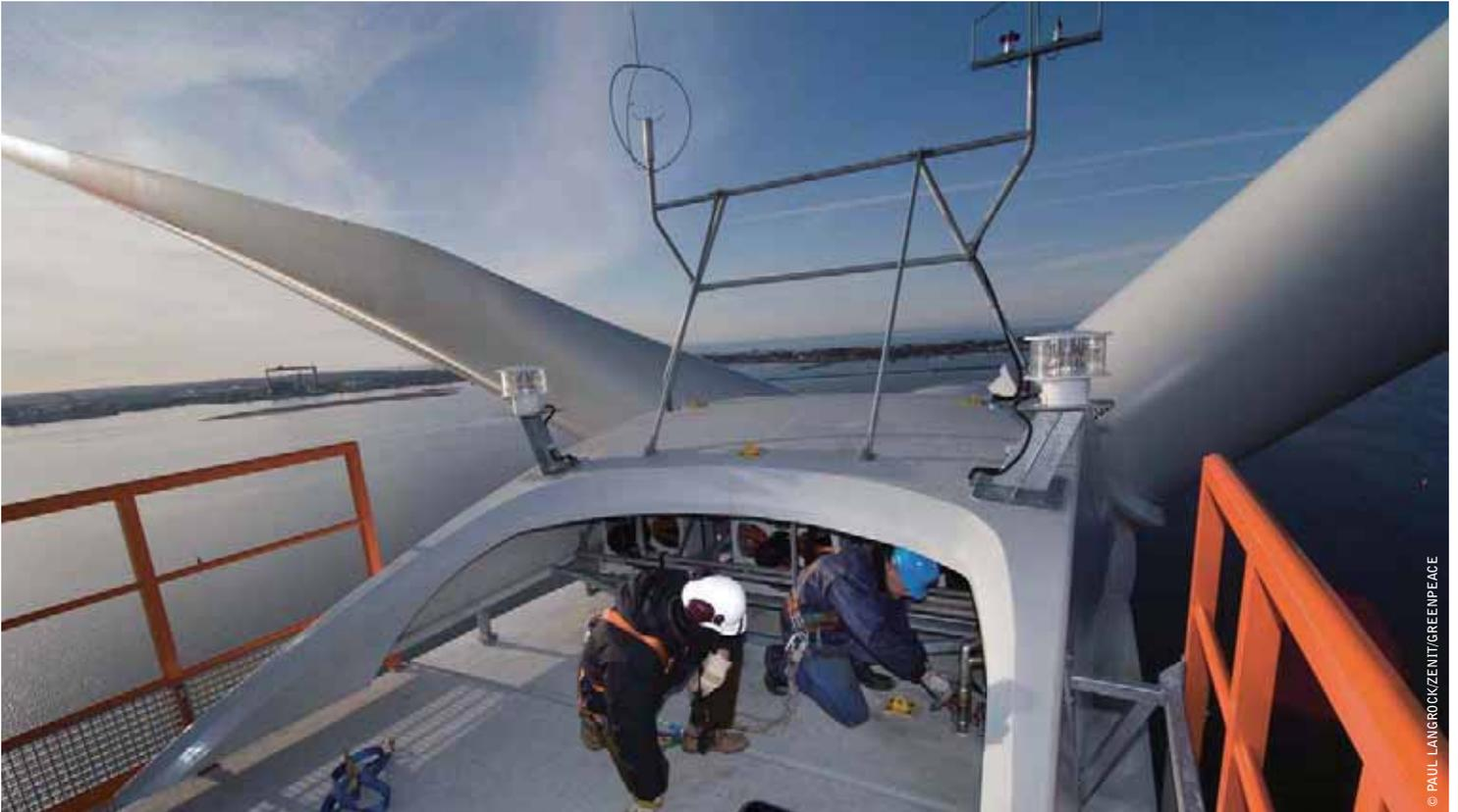
图片：风机测试 风机由德国NORDEX公司制造 位于罗斯托克港。这架风机功率为2500千瓦，在离岸条件下测试。到2007年，至少有十架这样的风机矗立在DARSS岛附近的波罗的海海域中。两位技师正在涡轮机内工作。
