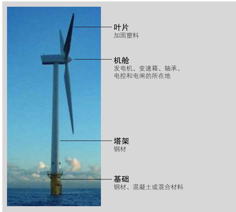
发展以及海上风电场的建设和维护。在中国大多数人对这一领域还感到比较陌生，因为到目前为止，中国还没有建成海上风电场。海上风电场建设所涉及的风机核心技术与陆上风电场相同，只是海上风电场的规模更大。因此，这里所作的基本描述对这两种风电场都适用。
