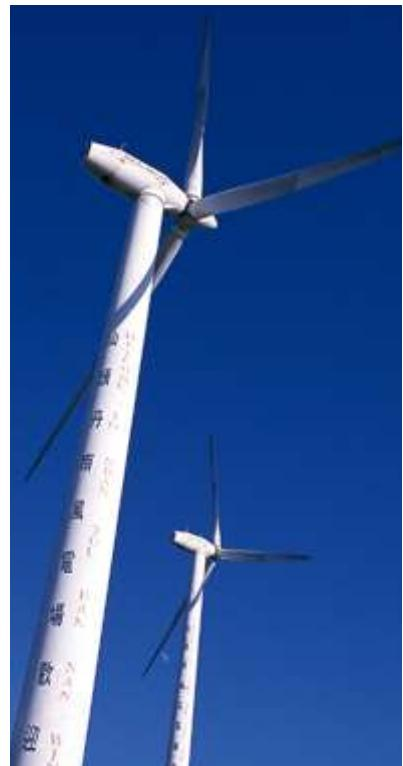
些风机会取消齿轮箱(例如直驱式风机是没有齿轮箱的)，然而大多数风机还会继续使用齿轮箱。不同的是风机将可能会使用永磁电动机和各种不同材料的叶片，而控制系统会变得越来越精密。成熟的海上风机可能看起来迥然不同，但是由于目前海上风电市场的开发程度有限，要预见它们的具体结构非常困难。
