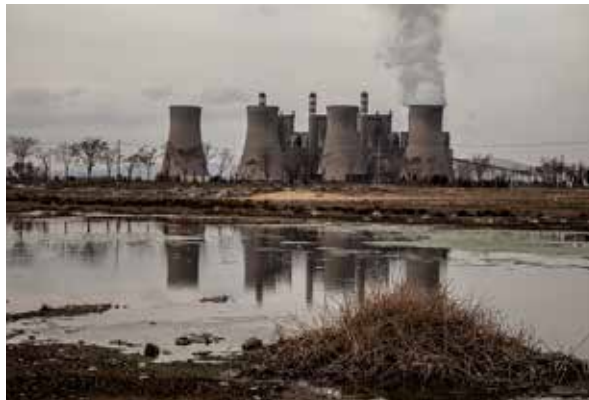
图 2014年3月，土耳其东南部的卡赫拉曼马拉什(Kahramanmaraş)，靠近阿夫辛勒比斯坦（Afsin-Elbistan）A、B燃煤电厂的凉水池。 © Umut Vedat/Greenpeace.
