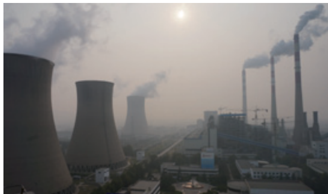
毗邻河北省石家庄市平山县南义羊村的河北西柏坡发电厂，规划装机容量为 2400 兆瓦，是河北南网最大电厂之一。© 绿色和平 / 林克
